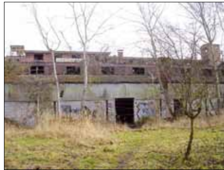
Ehemaliges Ofenhaus, Blick von Westen
