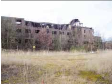
Ehemaliges Ofenhaus, Blick von Osten
