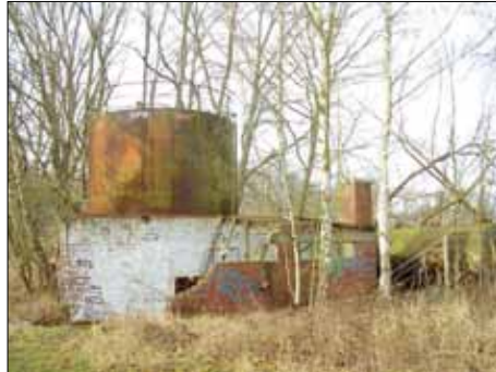
Ehemalige Aufbereitung, Blick von Süden
