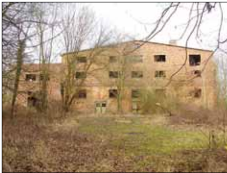
Ehemaliges Ofenhaus, Blick von Süden
