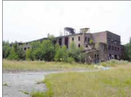
Ehemaliges Ofenhaus und Pressenhaus (rechts), Blick von Nordosten
