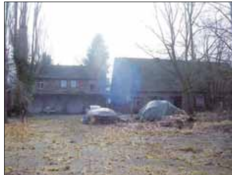
Ehemaliges Kameradschaftshaus und Büro (rechts), ehemaliges Wohnhaus (links), Blick von Norden
